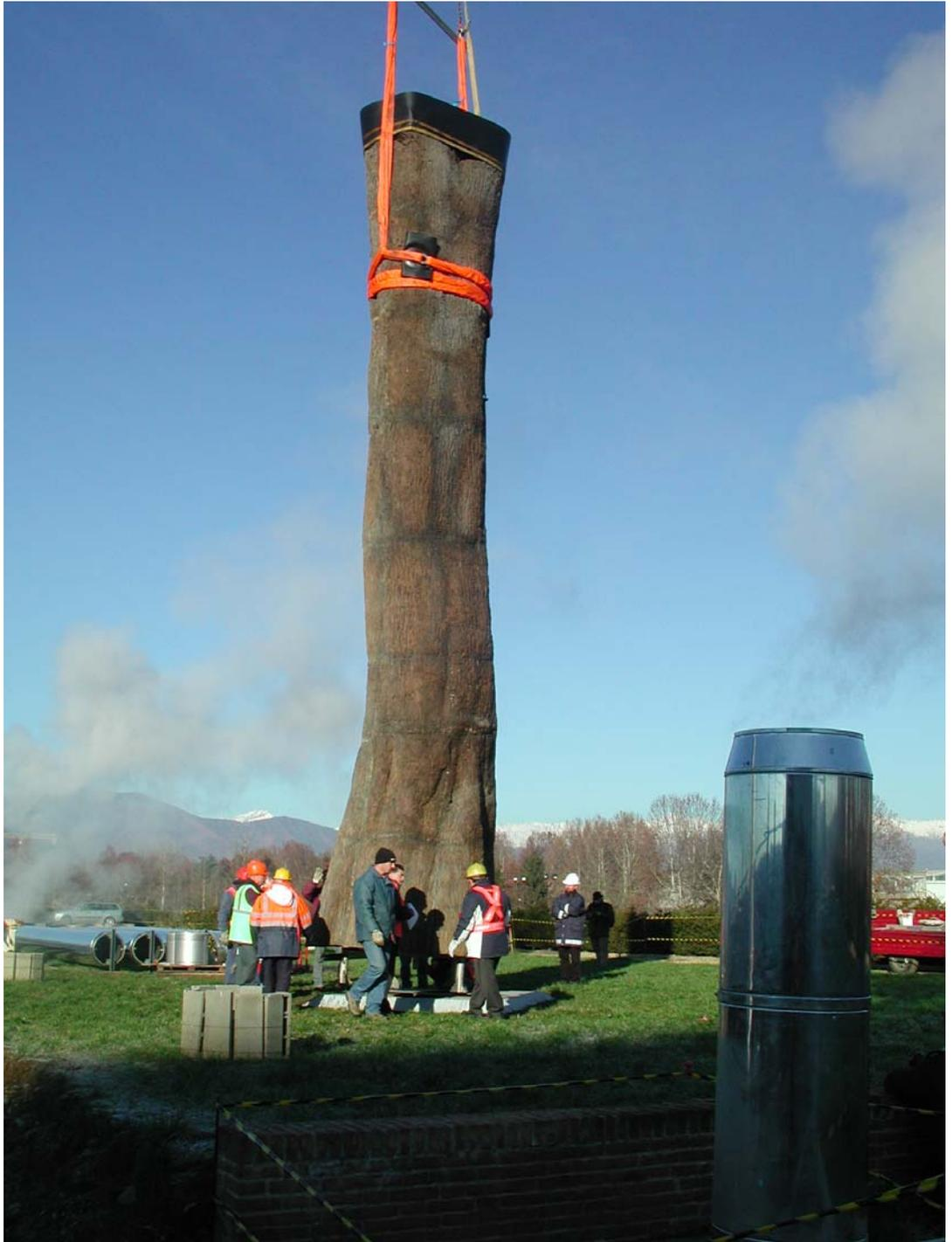
L'albero viene quindi posato sul basamento opportunamente predisposto per essere poi lavorato sulla parte esterna, completando il lavoro di levigatura e fresatura. Nella parte sottostante invece si provvede al collegamento dei quattro canali da fumo provenienti dalle caldaie.
