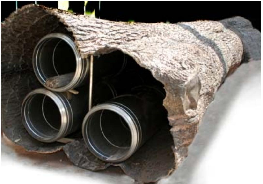
mente imponenti. Nelle foto si possono vedere alcune fasi della lavorazione e il difficilissimo posizionamento dei moduli di acciaio inox GBD Metaloterm MF che sono stati inseriti già montati, considerata l'impossibilità per i tecnici di poter lavorare fisicamente all'interno dell'albero a causa dello spazio ridotto. Anche lo
